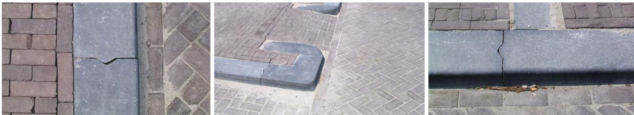
Rijbaan in klinkers, hardsteenkleurige trottoirbanden Trottoir gestraat met dezelfde klinkers
