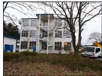
Figuur 5. Bebouwing voormalige Bata-fabriek, grenzend aan onbebouwd deel.
