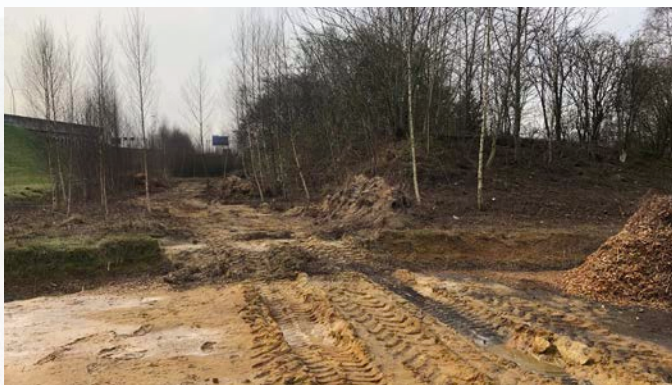
Grondwerk, dichte bodem. Ondoordringbare onderlaag en veel regen hebben de aanleg vertraagd!
