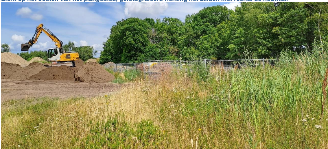
Zicht op het oosten van het plangebied, werkzaamheden vinden plaats ten westen van het houtopstand aan de oostgrens van het plangebied.
