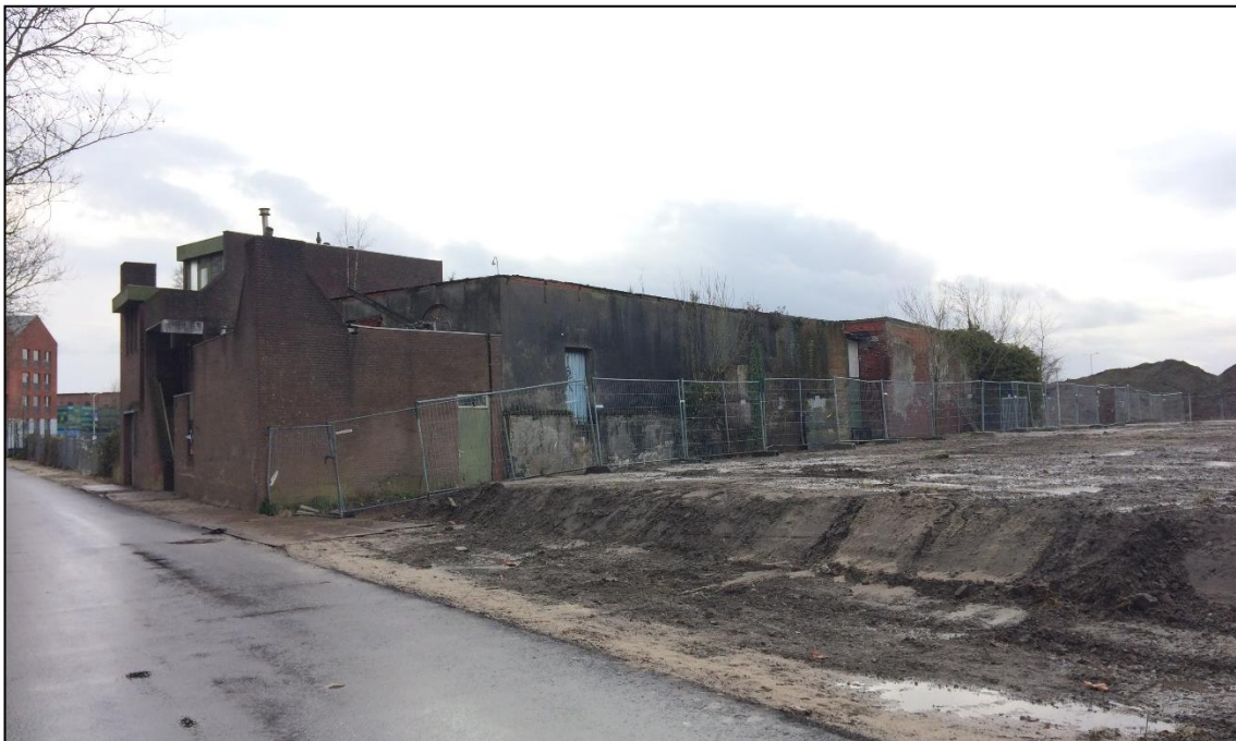
Foto 3: Het overgebleven bedrijfspand en de saneringswerkzaamheden rondom het plangebied.
