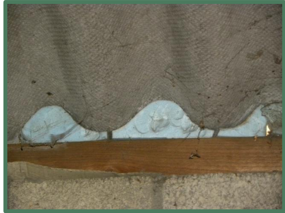
Foto 26: Golfplaten gesloten met vogelschroot.
