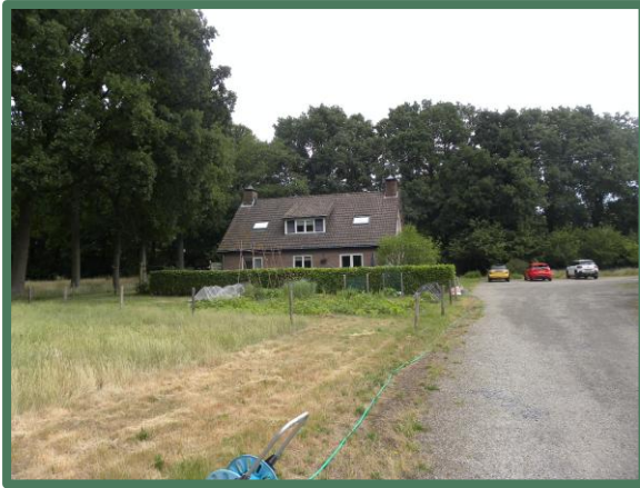
Foto 7: Woning vanaf het westen.
