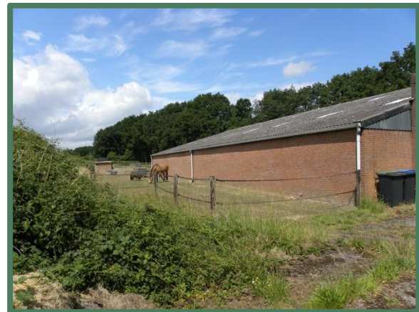
Foto 12: Loods met weide vanaf het noordoosten.
