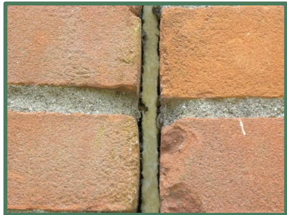
Foto 29: Dilatatievoeg opgevuld met isolatiemateriaal.
