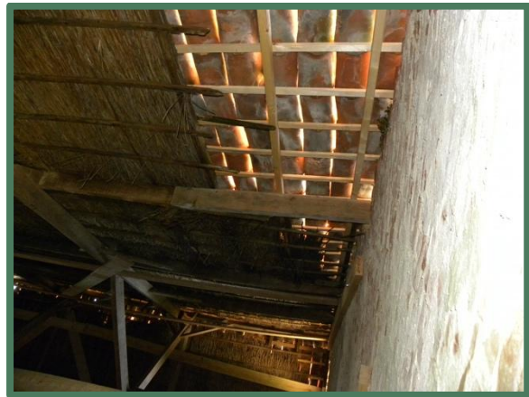
Foto 33: Deels beschoten dak van de schuur.
