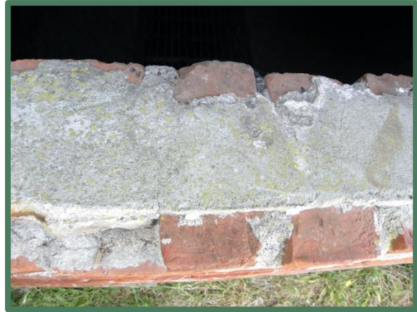
Foto 31: Boven aanzicht op gesloten dubbel steense gevel.
