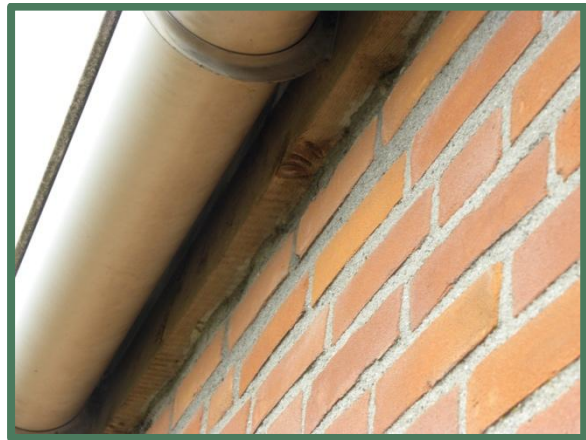
Foto 28: Muurplaat op de gevel.
