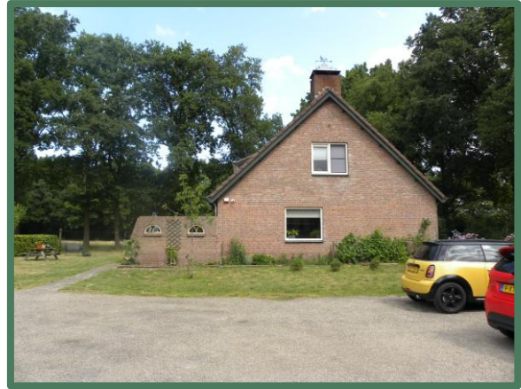
Foto 8: Woning vanaf het zuiden.
