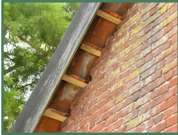
Foto 30: Ruimte boven kopgevels.
