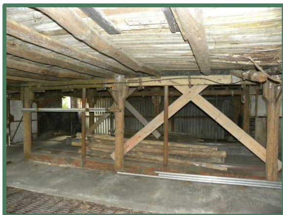
Foto 36: Binnenzijde schuur bezemschoon.
