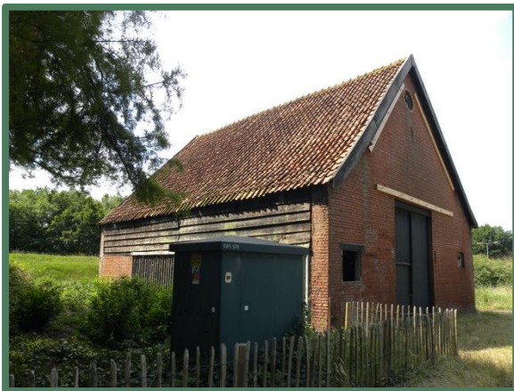
Foto 17: Schuur vanaf het noordoosten.
