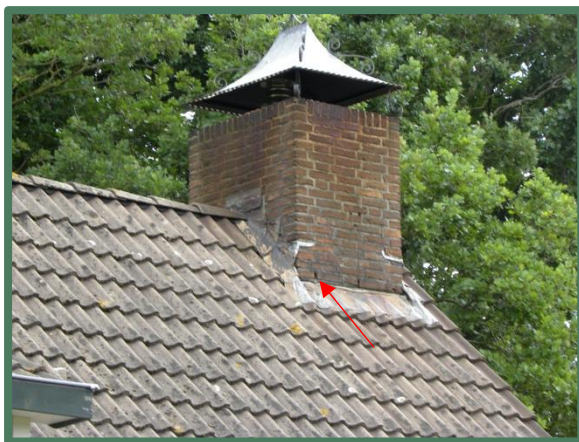
Foto 34: Enkele open stootvoeg in de schoorsteen.
