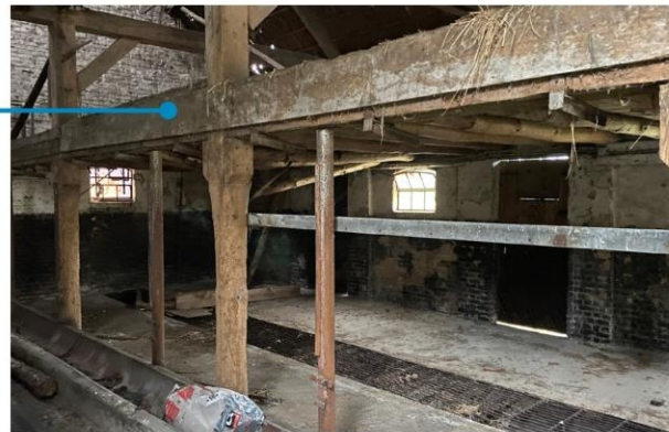
trog/kribben van metselwerk met schotelvormige keramische afwerking
