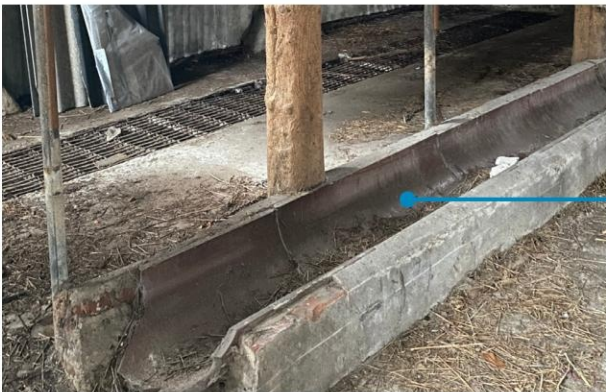
trog/kribben van metselwerk met schotelvormige keramische afwerking
