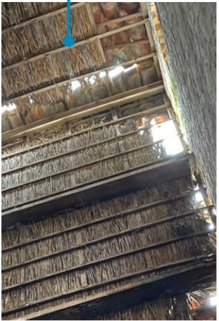
kapconstructie sporenkap met gordingen incl. rietlatten
