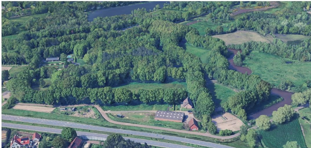
3D overzicht vanaf complex fort Pinssen en terrein Stierenstal, bron: Google Earth 2025
