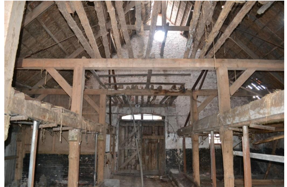
Dekbalkgebinten richting voorgevel.
