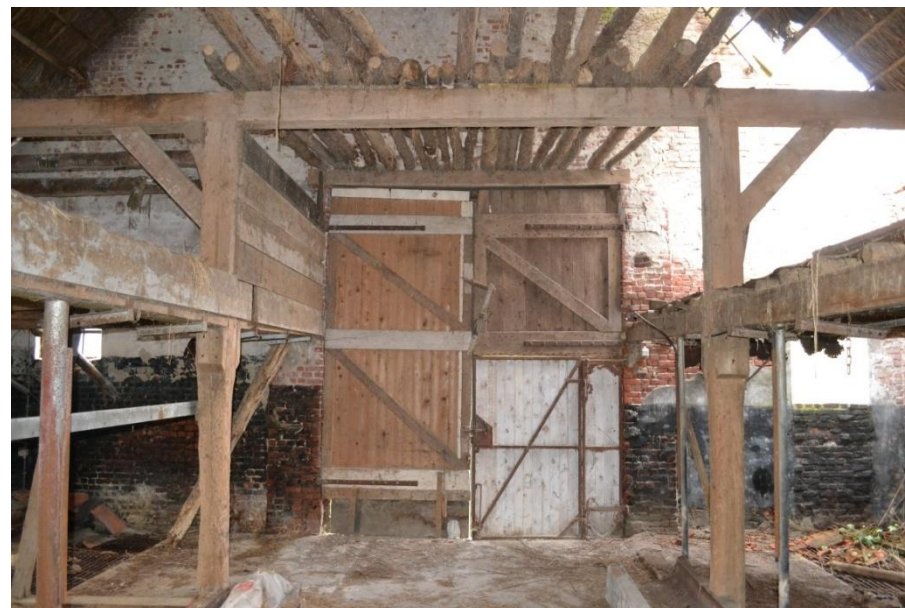
Interieur met dekbalkgebint.
