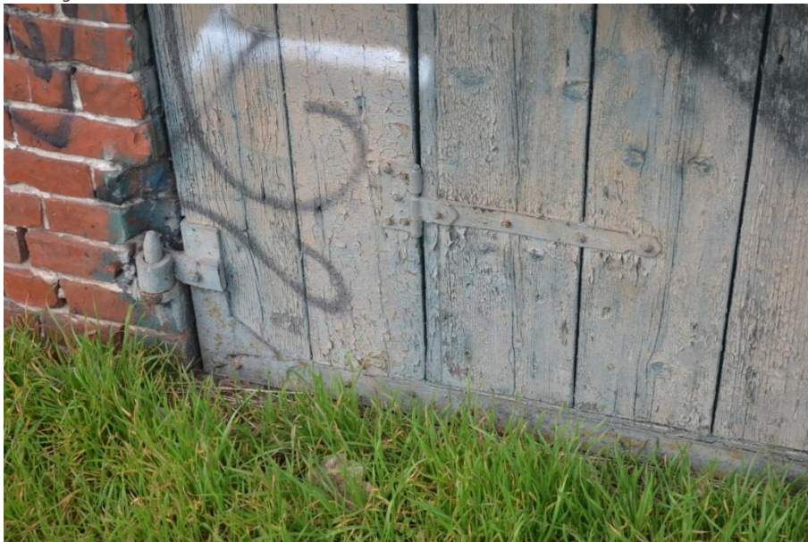
Later toegevoegd loopdeur, met afgezaagd geheng links.
