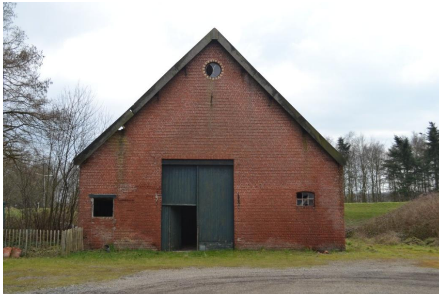
Achtergevel van de stal.
