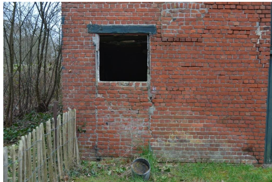
Staldeur en stalvenster in het metselwerk zichtbaar.
