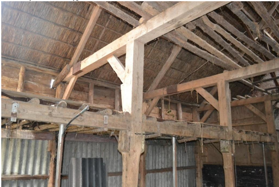
Dekbalkgebinten richting rechterzijgevel.
