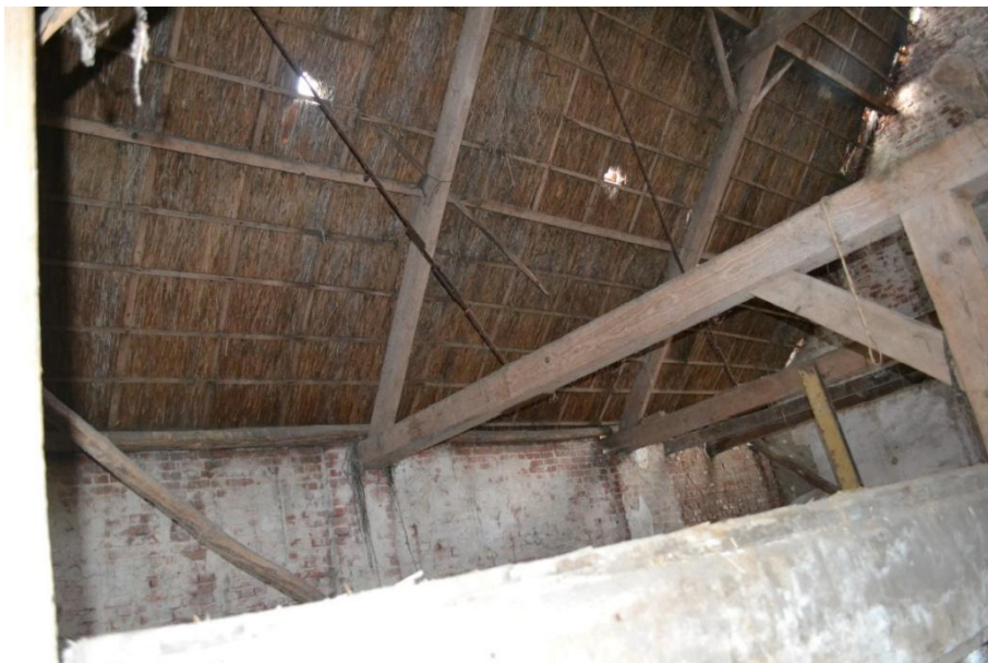
Dekbalkgebint richting linkerzijgevel.
