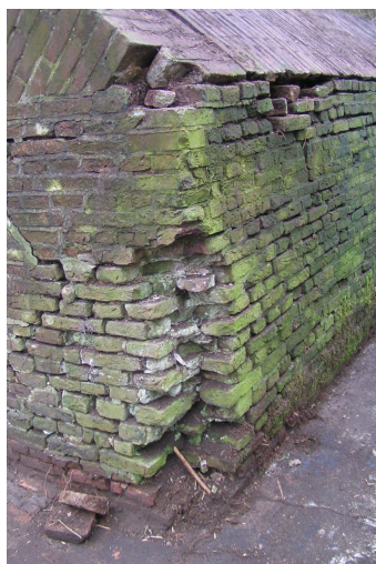
Fig.16. Opnames van het verwaarloosde muurwerk uit de 18 de eeuw aan de noordwestkant van de Waterschans.
