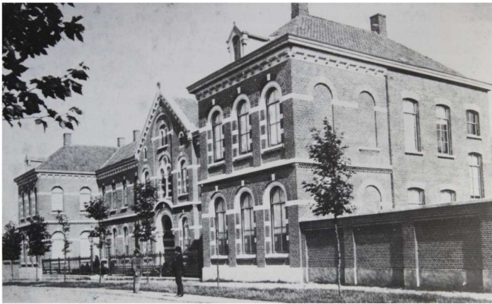
Afbeelding 4: Opname uit de jaren dertig waaruit de oorspronkelijke structuur van het gasthuis duidelijk blijkt.
