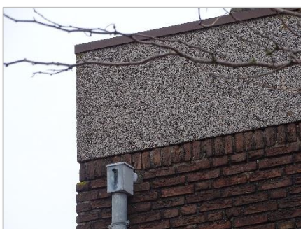
Foto 11: Aansluiting goot op gebouw.
