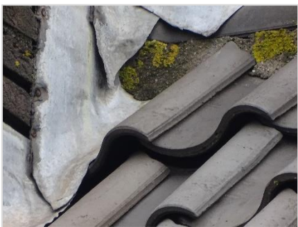
Foto 8: Dakpanligging bij de schoorsteen.
