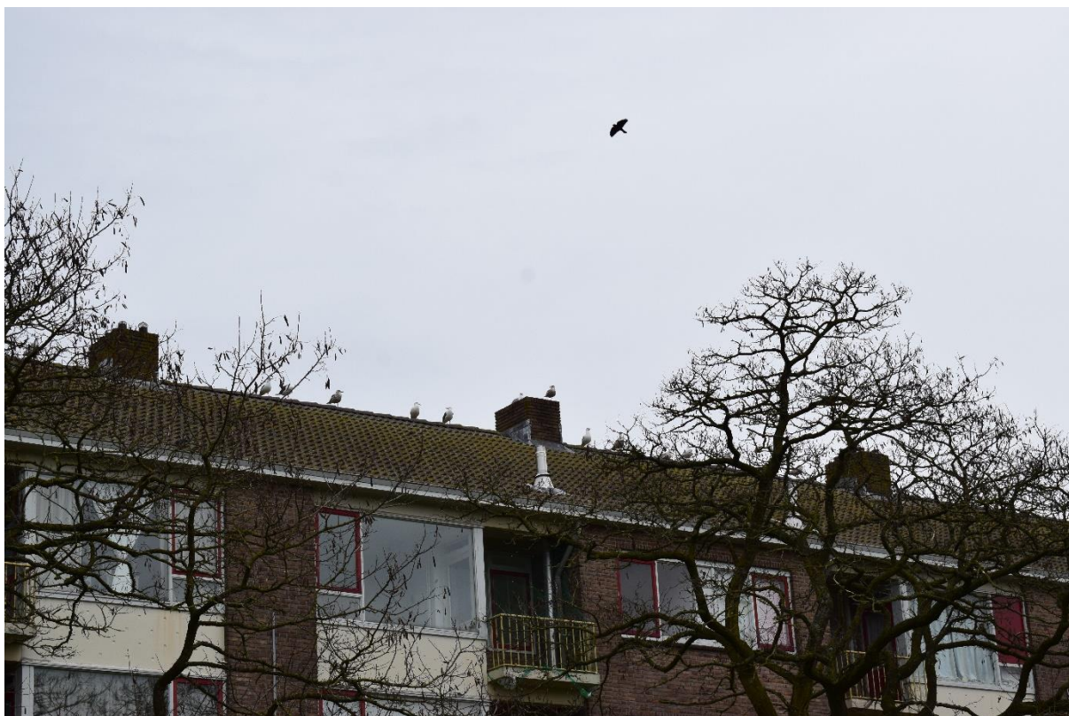
Figuur 2. Pannendaken van de hoogbouw complexen.
