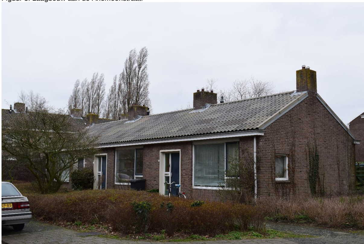
Figuur 4. Laagbouw aan de Teunisbloemstraat met vernieuwde dakpannen en platen onder de kantpannen.
