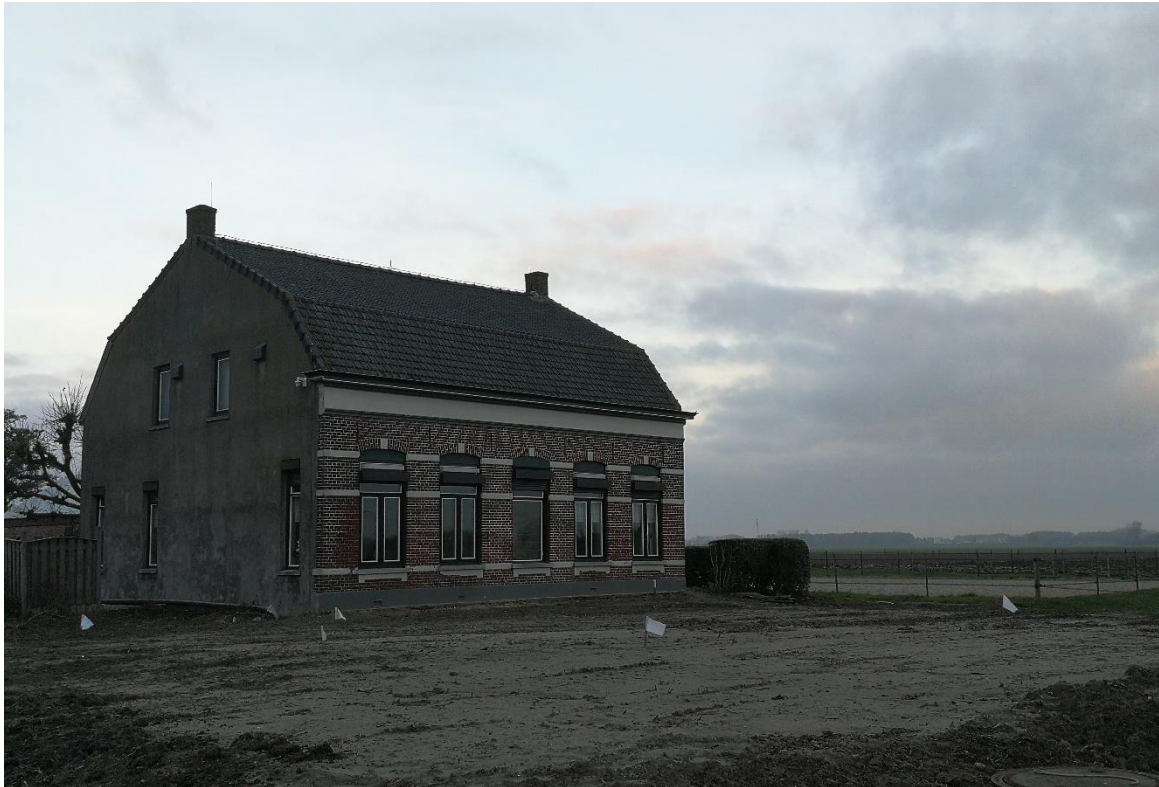
Figuur 2 Bedrijfswoning in het oostelijk deel van het projectgebied, met vooraan gelegen braakliggend terrein, waarop de nieuw te bouwen bedrijfswoning zal worden gerealiseerd.
