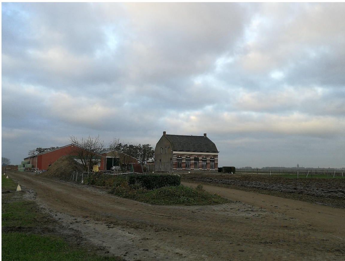
Figuur 3 Volledige terrein met bedrijfswoning en opstallen, gezien vanuit het zuidoosten.
