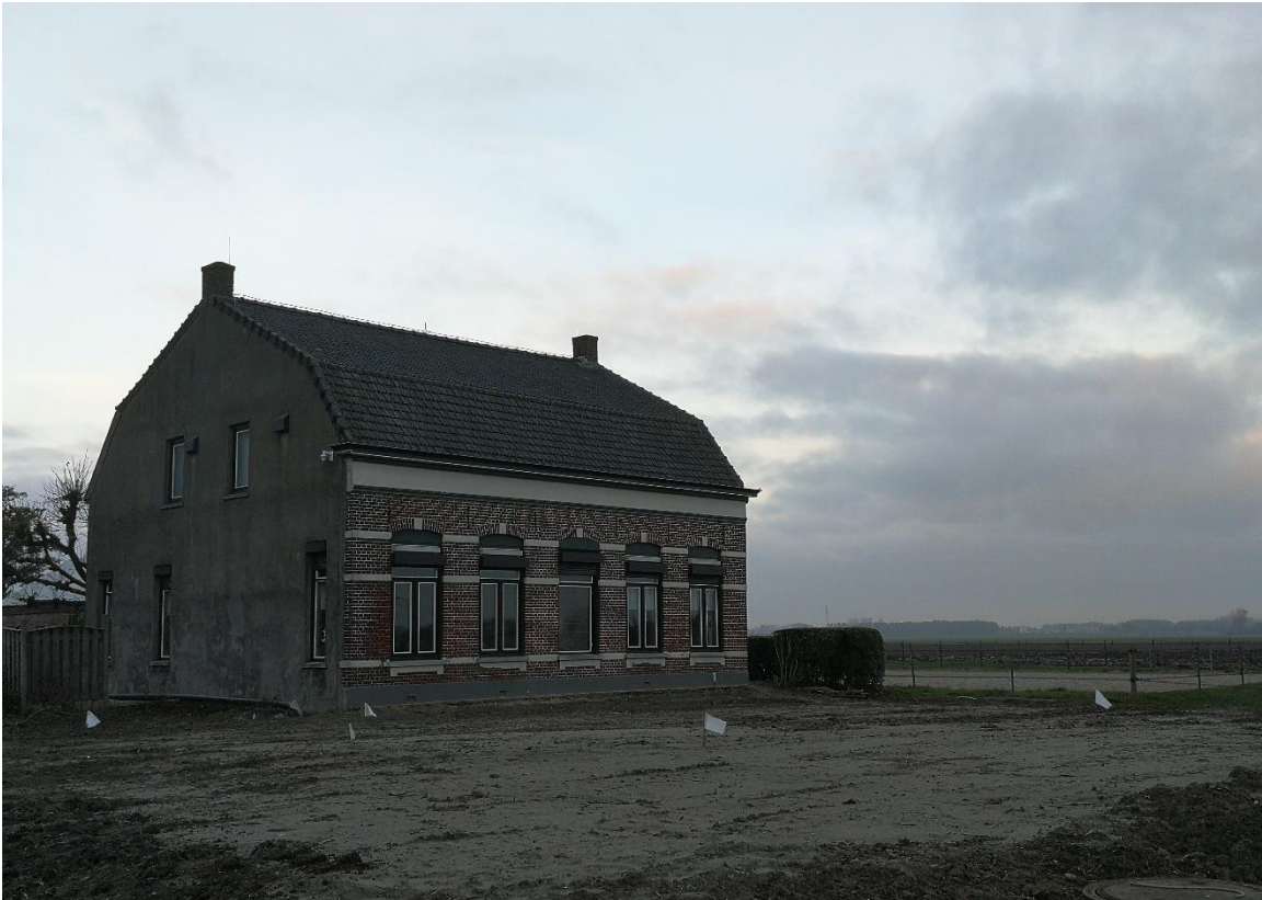
Figuur 2 Bedrijfswoning in het oostelijk deel van het projectgebied, met vooraan gelegen braakliggend terrein, waarop de nieuw te bouwen bedrijfswoning zal worden gerealiseerd.
