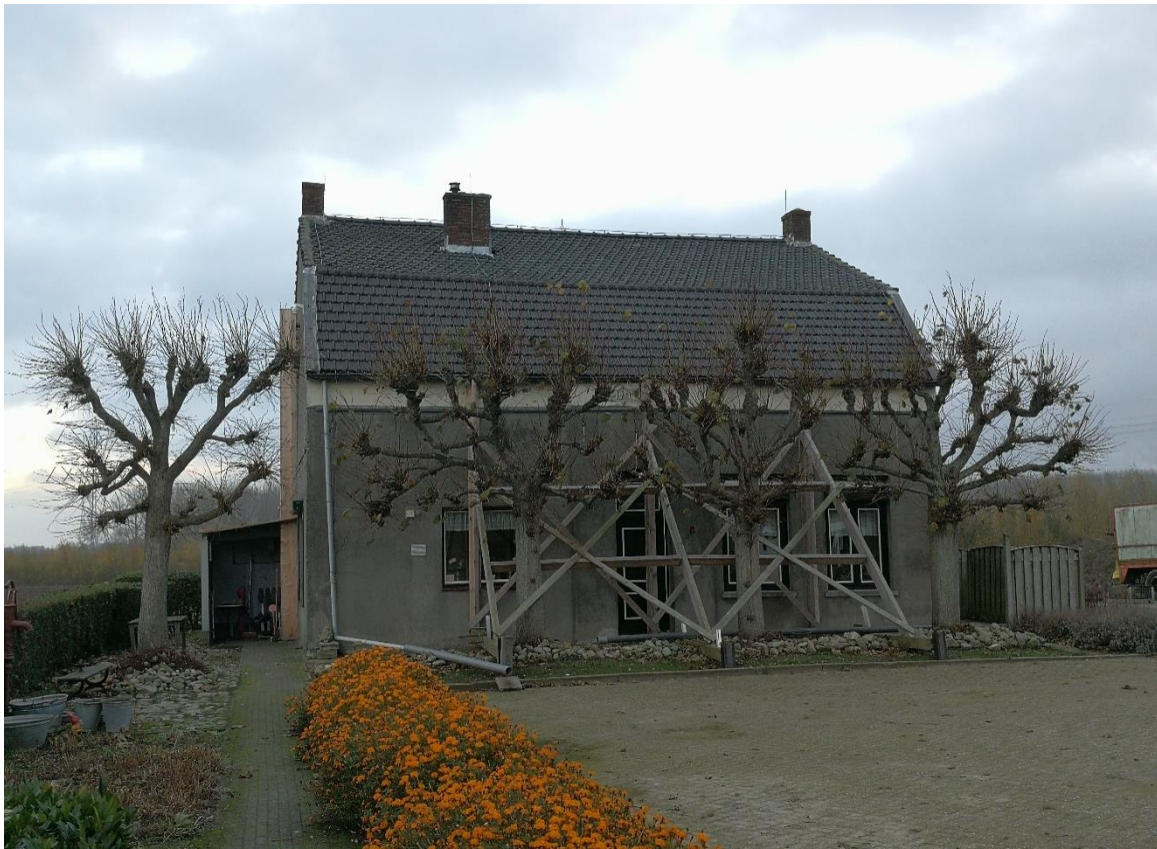
Figuur 6 Huidige bedrijfswoning wordt gestut om instorting te voorkomen.
