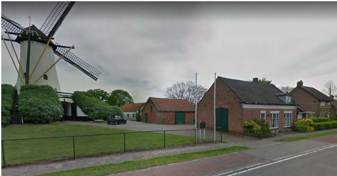
Vooraanzicht bestaande situatie
