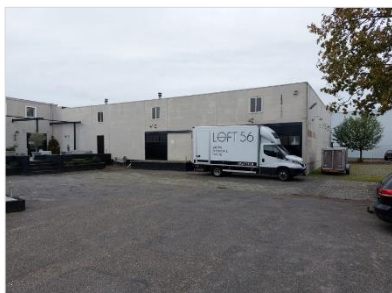
Figuur 2-7. Gebouw F (betonnen aanbouw).
