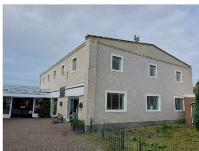
Figuur 2-4. Gebouw A.
