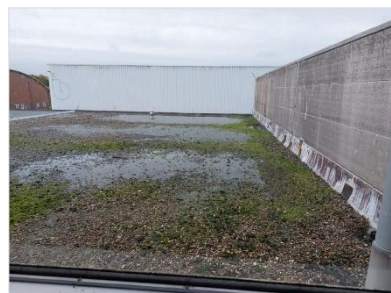
Figuur 2-11. Dak gebouw D.
