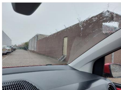
Figuur 2-10. Achterzijde gebouw D.
