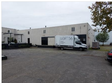
Figuur 2-7. Gebouw F (betonnen aanbouw).
