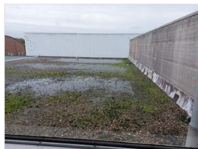
Figuur 2-11. Dak gebouw D.
