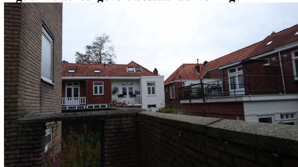
Figuur 6: achtergevels bestaande woningen
