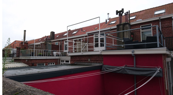
Figuur 4: achtergevels bestaande woningen
