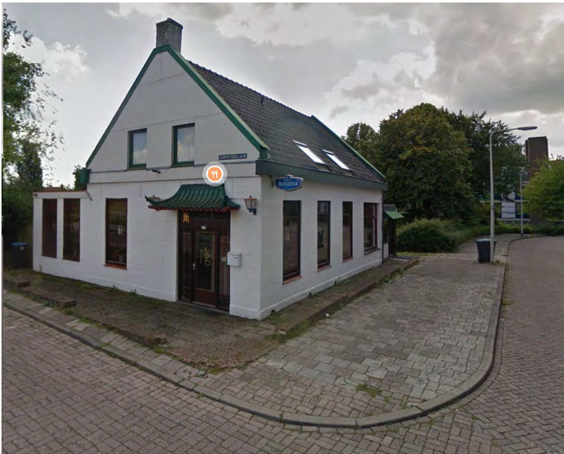
Figuur 4.5 - Beeldbepalend gebouw aan de overkant van de Casper Fagellaan (Google Street View, 2019)
