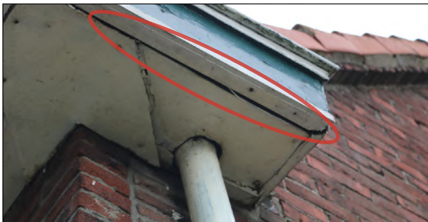
Figuur: aangrenzend aan het plangebied zijn geschikte spleten aangetroffen waar vleermuizen in kunnen vliegen. Hier kunnen verblijfplaatsen van vleermuizen aanwezig zijn.
