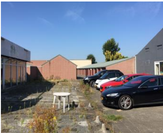
Afbeelding 6: foto binnenterrein in gebruik als parkeergelegenheid
