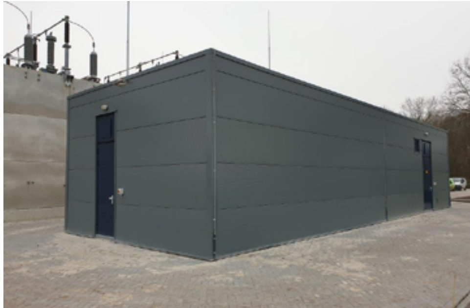
Voorbeeld mudulkair gebouw en achterliggend trafo-station
