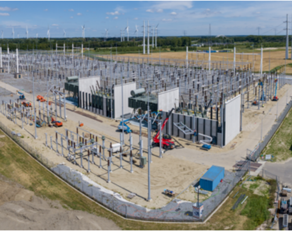
Voorbeeld inrichting hoogspanningsstation
