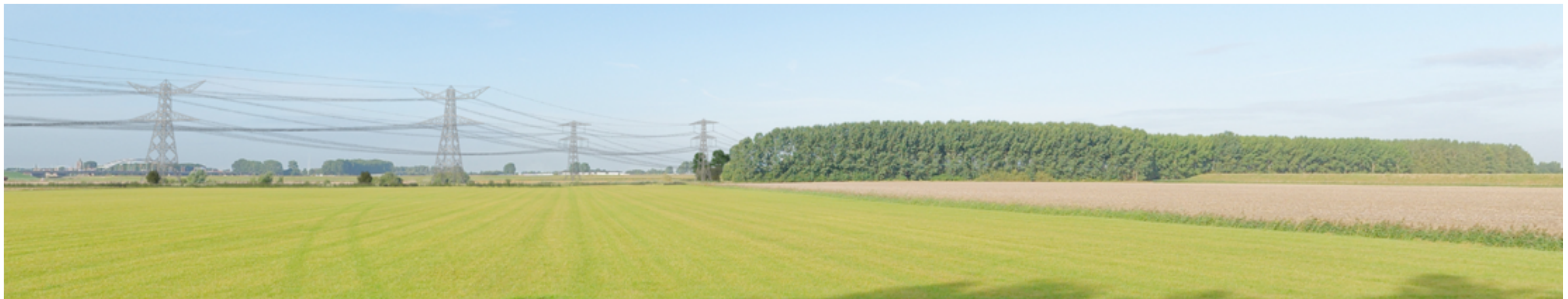
Positie 3: Hoogspanningsstation oostzijde met landschappelijke inpassing en toevoeging nieuwe vakwerkmasten
