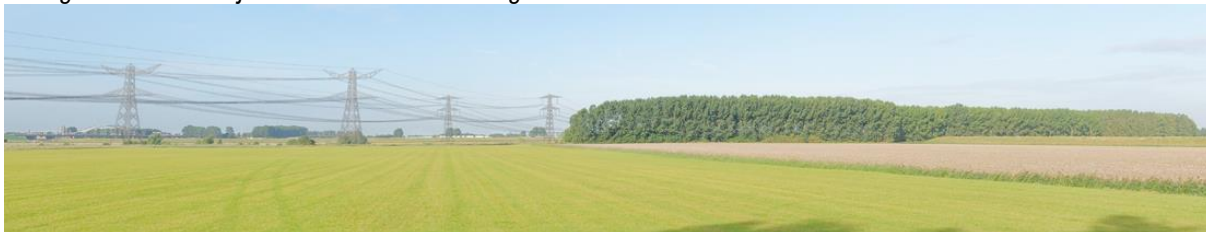
Hoogspanningsstation oostzijde zonder landschappelijke inpassing en toevoeging nieuwe vakwerkmasten
