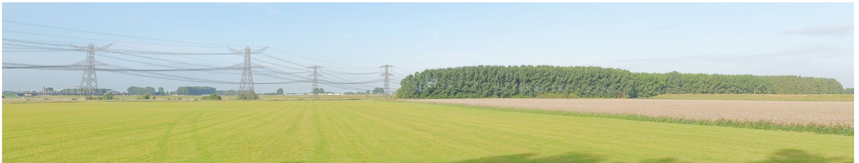
Positie 3: Hoogspanningsstation oostzijde zonder landschappelijke inpassing en toevoeging nieuwe vakwerkmasten
