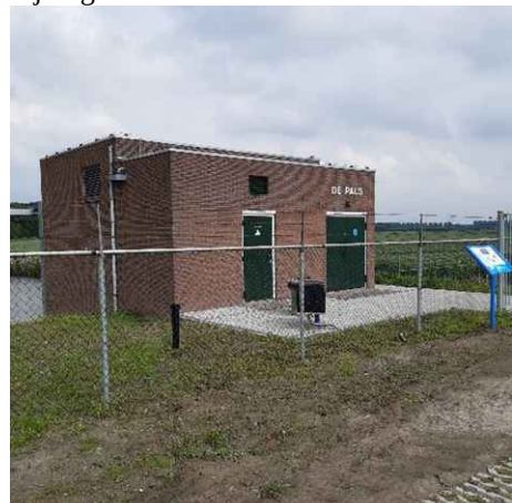
Fotonummer: 12 Omschrijving: Gemaal De Pals
