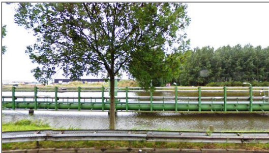
Gestuurde boring onder de Theodorushaven
