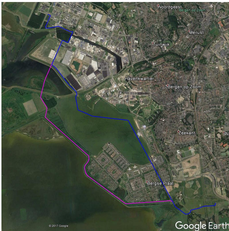
Figuur 1: Verlegging zuurstofleiding t.h.v. Bergen op Zoom (blauw: bestaand tracé, roze: nieuw tracé), bron: Google Earth [Ref. 7]
