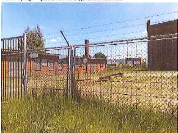
Fotonummer: 3 Omschrijving: bijgebouw voormalige suikerfabriek
