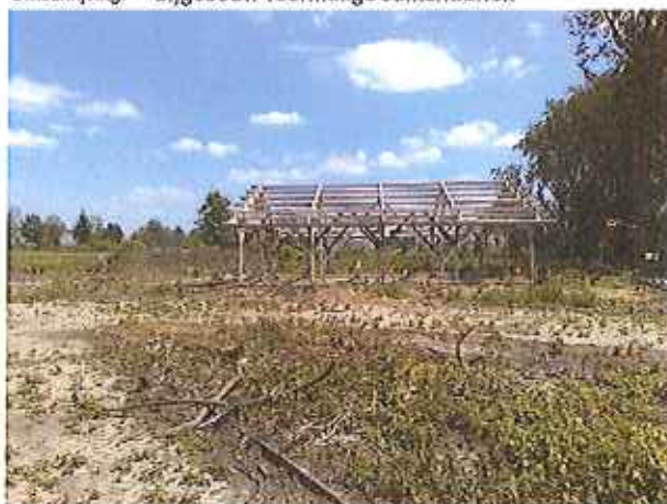
Fotonummer: 9 Omschrijving: zuidelijk terreindeel voormalige suikerfabriek
