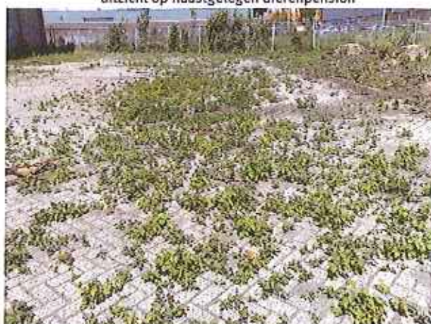
Fotonummer: 17 Omschrijving: klinkerverharding begroeid met brandnetels oostelijk terreindeel voormalige suikerfabriek
