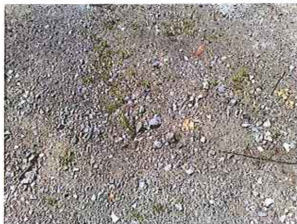
Fotonummer: 20 Omschrijving: pulnverharding westelijk terreindeel voormalige suikerfabriek
