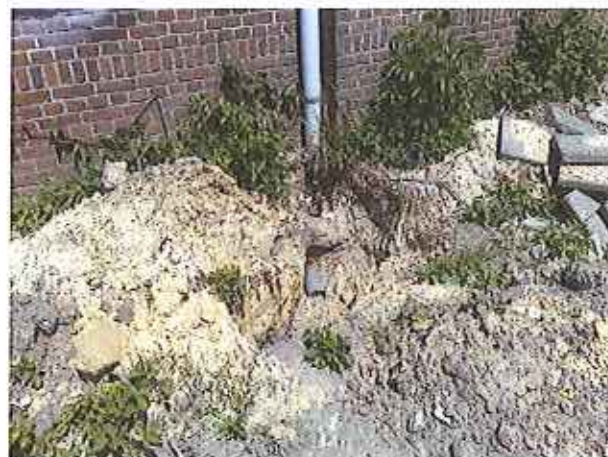
Fotonummer: 8 Omschrijving: zuidzijde pand; graafwerkzaamheden
