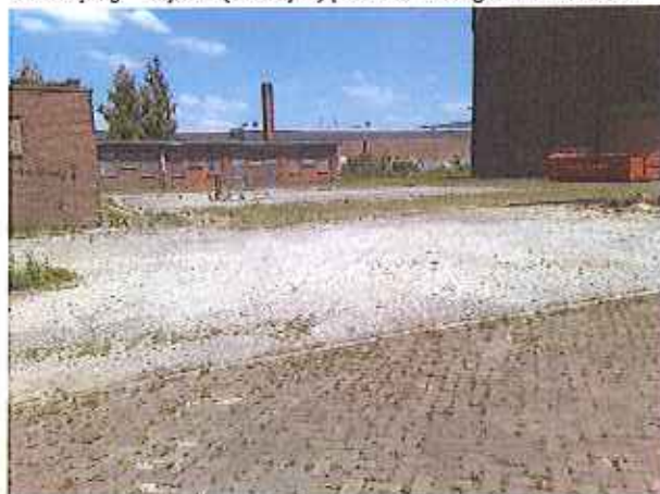
Fotonummer: 4 Omschrijving: puinlaag voormalige suikerfabriek
