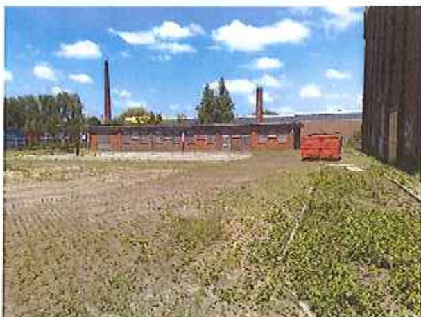
Fotonummer: 7 Omschrijving: bijgebouw voormalige suikerfabriek
