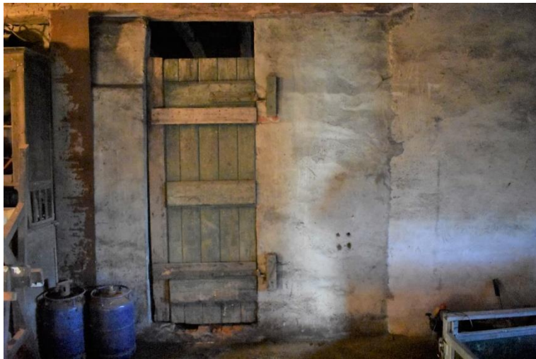
Deur tussen grupstal en schuur.
