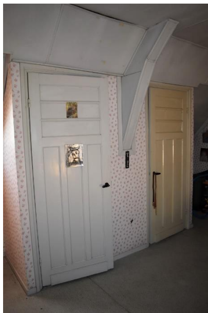
Inbouwkasten met oorspronkelijke paneeldeuren met bakelieten klinken.
