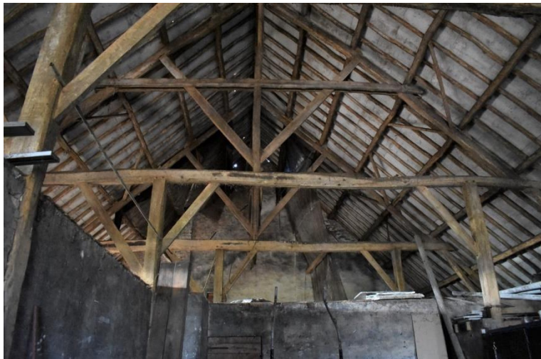
Vijf dekbalkgebinten met daarop nokstijlspanten.
