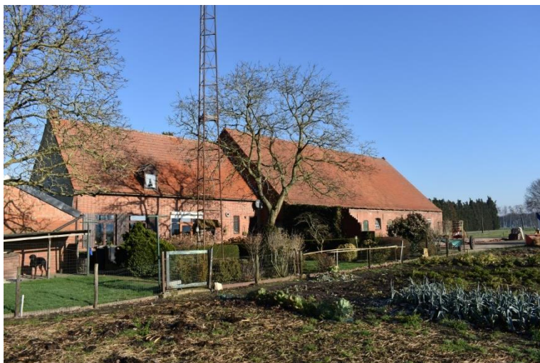
Achtergevel van de boerderij.
