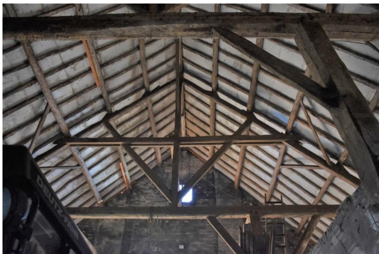
Nokstijlspant met tussenbalk en schoren.
