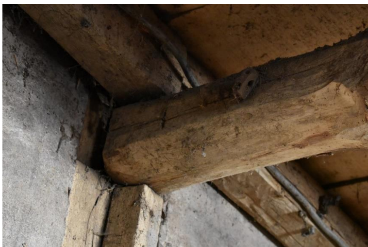
Telmerk I op de moerbalk in de grupstal.
