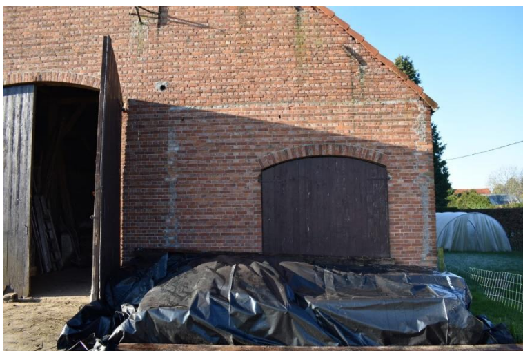
Linkerzijgevel met twee dubbele deeldeuren.
