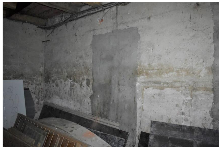
Dichtgemetselde opening naar de tasruimte.
