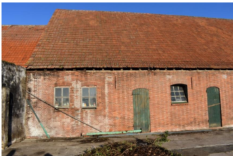
Achtergevel bedrijfsgedeelte met links vernieuwde betonvensters.
