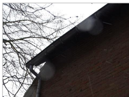
Foto 5: Dakrand zuidzijde Vlaamse schuur.
