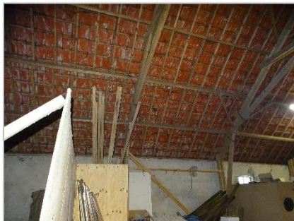
Foto 15: Binnenzijde dak Vlaamse schuur (niet afgewerkt/open)
