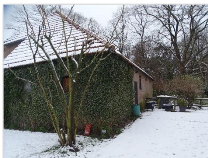
Foto 8: Noord- en westzijde Vlaamse schuur.
