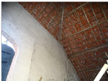
Foto 14: Binnenzijde dak Vlaamse schuur (niet afgewerkt/open).
