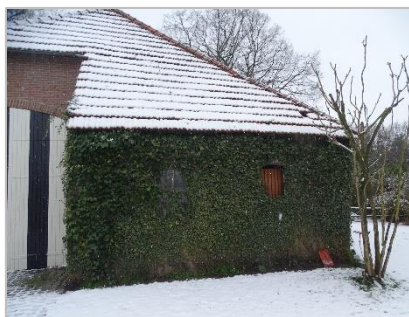
Foto 7: Noordzijde Vlaamse schuur.
