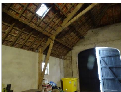
Foto 17: Binnenzijde dak Vlaamse schuur (niet afgewerkt/open)
