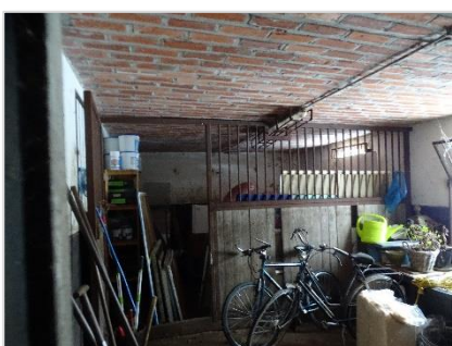
Foto 19: Afgesloten berghok binnen Vlaamse schuur.
