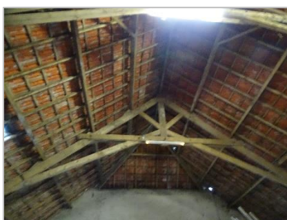
Foto 18: Binnenzijde dak Vlaamse schuur (niet afgewerkt/open)
