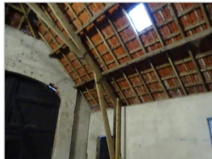
Foto 16: Binnenzijde dak Vlaamse schuur (niet afgewerkt/open)
