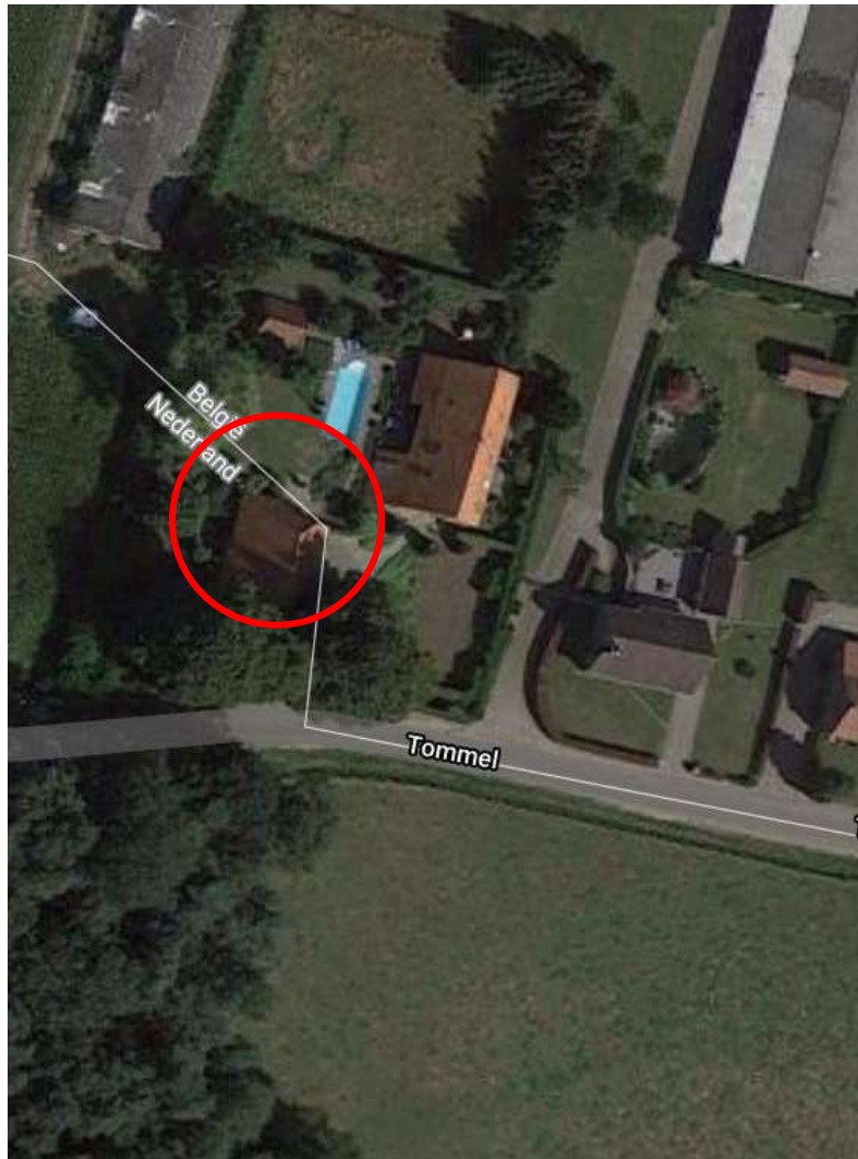
Figuur 5 - Luchtfoto Tommel 10 (bron: Google Earth)
