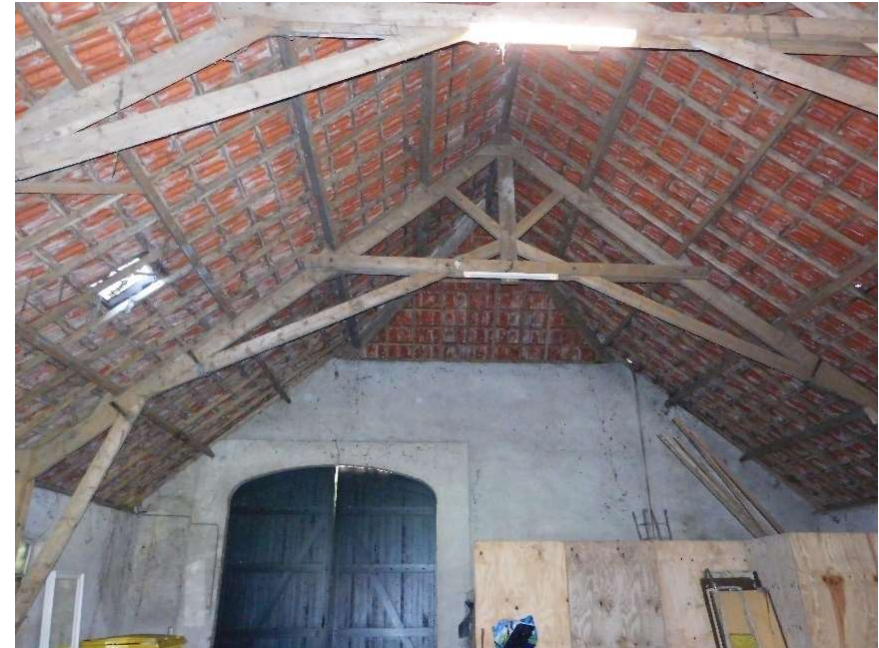
Figuur 10 - Interieur stal Tommel 10; opvallend zijn de 3 houten zg. Duitse spanten.
