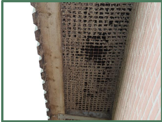
Foto 9: Overzicht rooster onderzijde loods.
