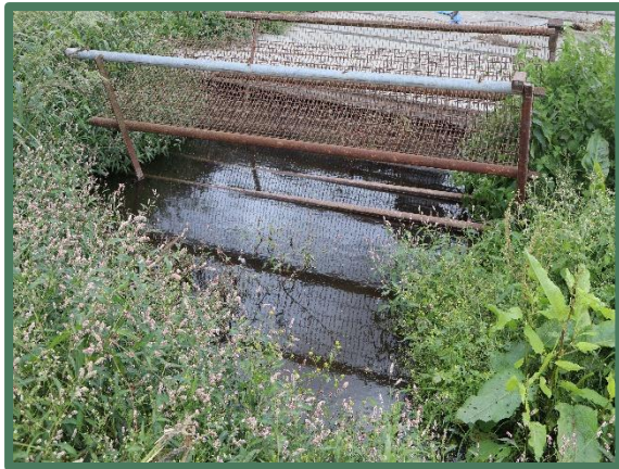
Foto 23: Afwateringskuil naast kippenstal/loods.
