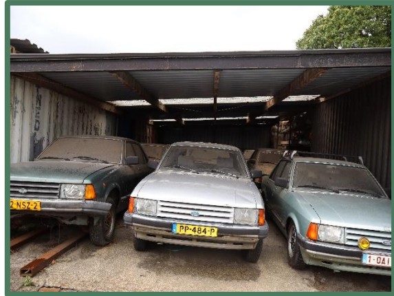
Foto 10: Overzicht linker te slopen overkapping.
