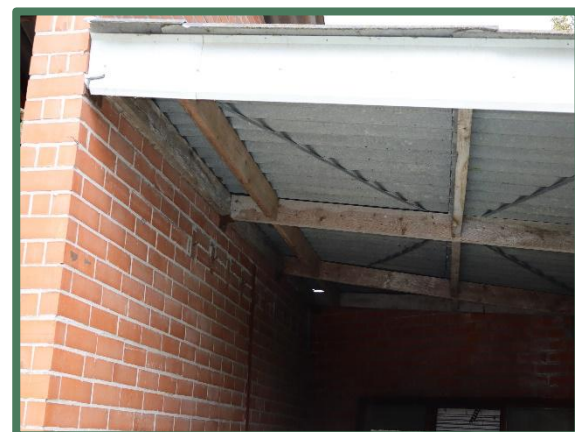
Foto 20: Muurrand rechter te slopen overkapping.
