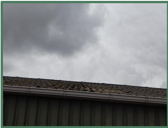
Foto 5: Overzicht dak van de loods.
