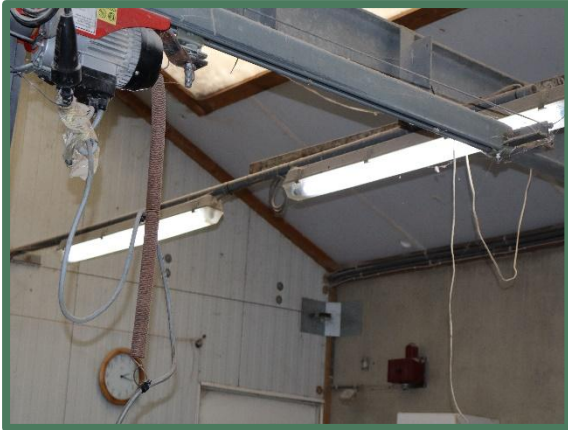
Foto 3: Overzicht binnenzijde loods.
