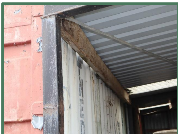
Foto 19: Muurrand linker te slopen overkapping.
