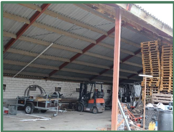
Foto 7: Overzicht opslag overkapping.
