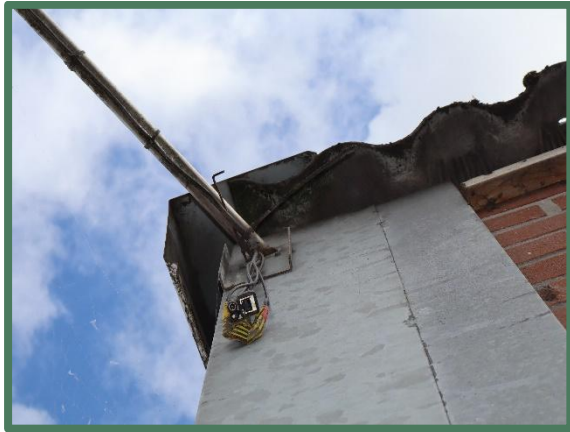
Foto 15: Dakrand met vogelschroot.
