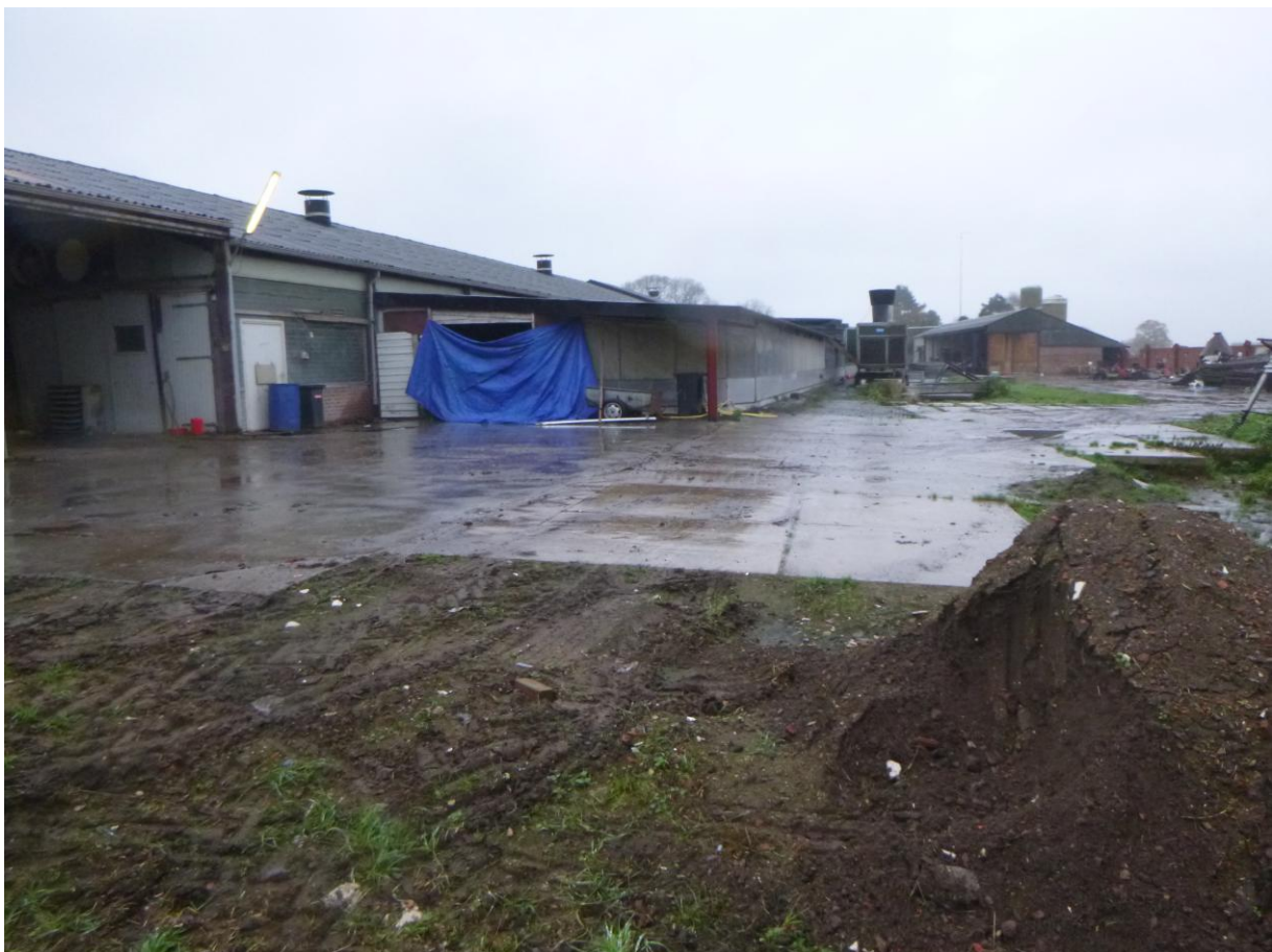
Figuur 26: Het plangebied nabij boorpunt 14, gezien in noordelijke richting.
