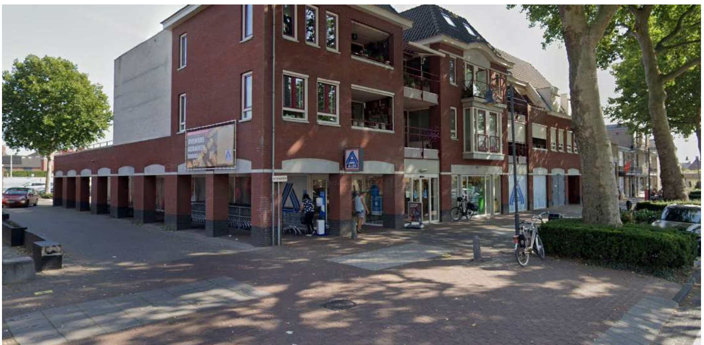
Figuur 1.1 Impressie huidige winkel Aldi Stationsstraat 29 (bron: Google Streetview, 2020)
