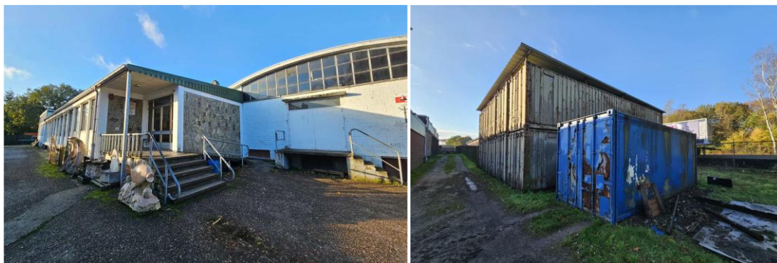
Figuur 6: voormalige bedrijfswoning met Markthal (rechts), Opslag (links)
