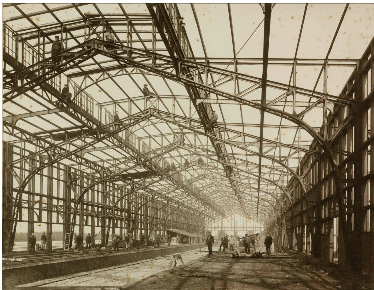
Figuur 2. Afbeelding van de bouwwerkzaamheden van de grote douaneloods behorende bij het grensstation (Bron: Amalia van Solms).
