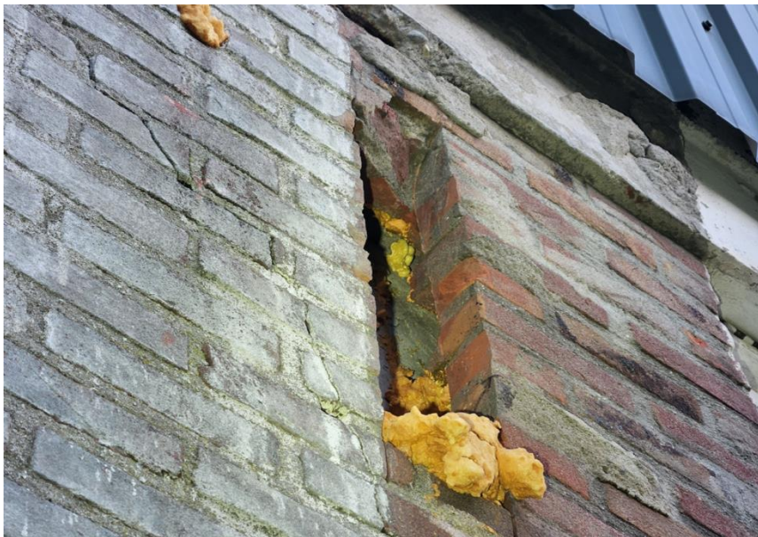
Figuur 15: Opening naar ruimten in de spouw in de zuidgevel
