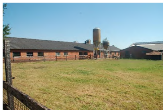
Afbeelding 20: voorzijde (zuiden) stal 5 met rechts gebouw 8
