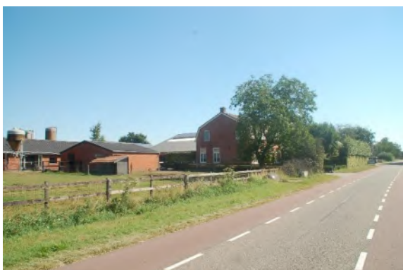
Afbeelding 19: gebouw 8 gezien vanaf de Oordeelsestraat
