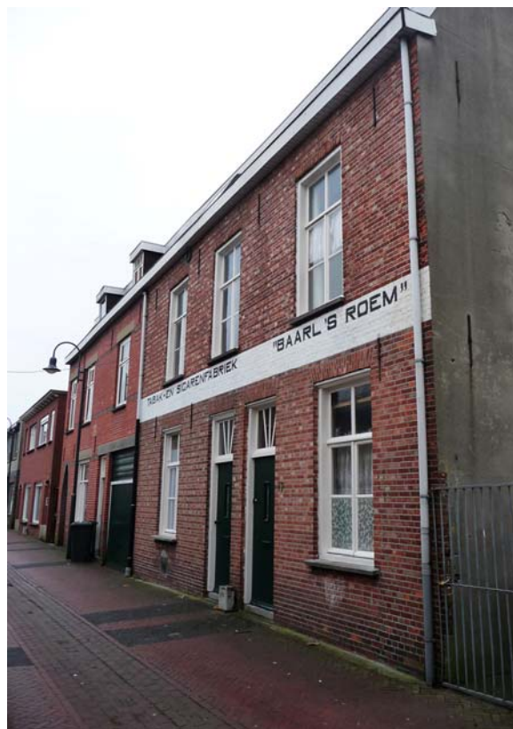
Voormalige sigarenfabriek aan de Roosakkerstraat
