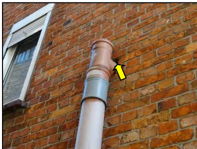
Figuur 13. Ruimte in de gevel achter de regenpijp.
