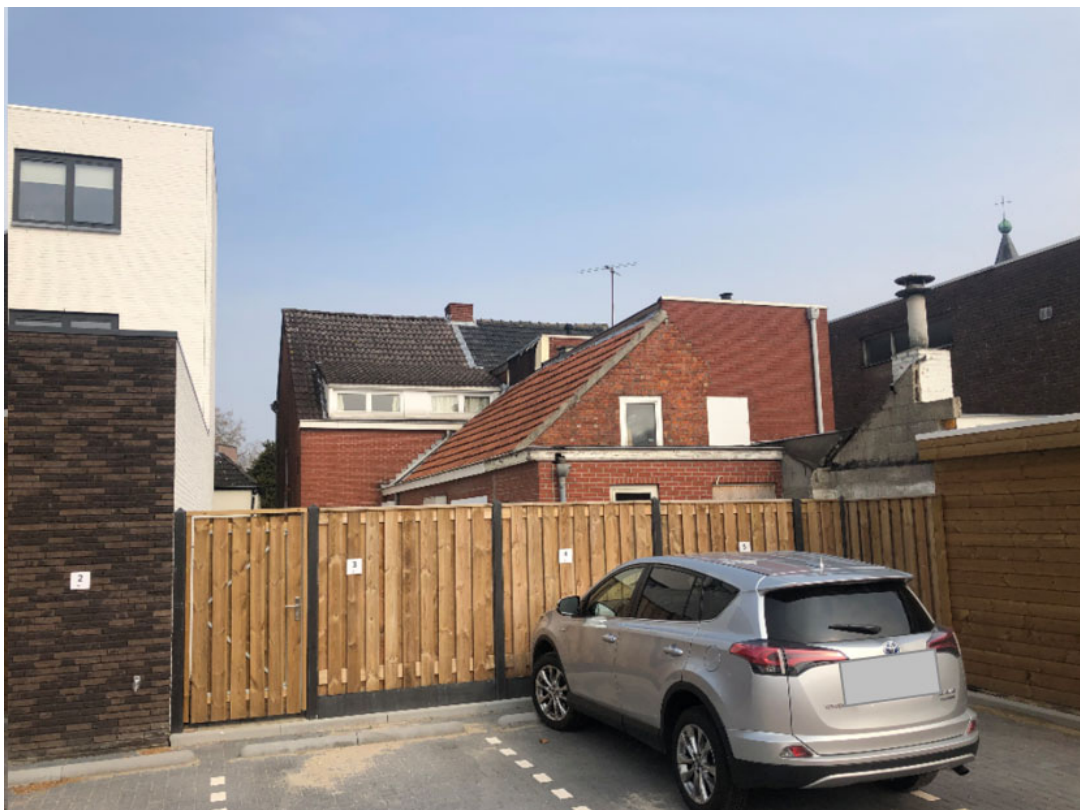
Figuur 2.6: Foto richting 5 van achterkant nummer 11 (Bron: Atelier2)
