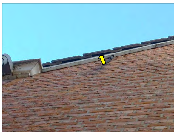
Figuur 11. Overhangende dakpannen.
