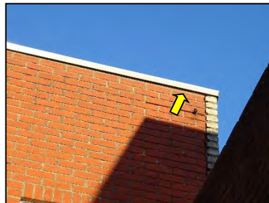
Figuur 14. Ruimte onder de daktrim.
