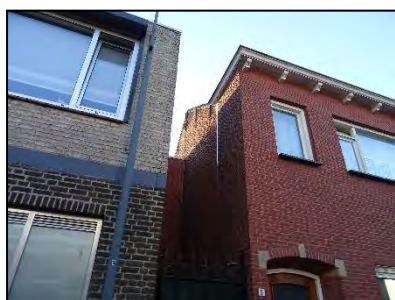
Figuur 6. Roosakkerstraat 9 en het gebouw grenzend ten oosten.
