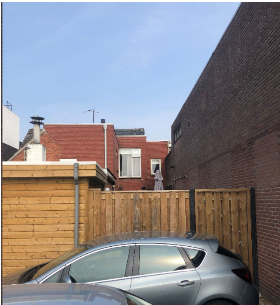
Figuur 2.7: Foto richting 6 van achterkant nummer 9 (Bron: Atelier2)
