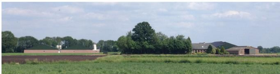
Zicht op de westzijde van het perceel, vanuit de doorgaande weg Pineind.
