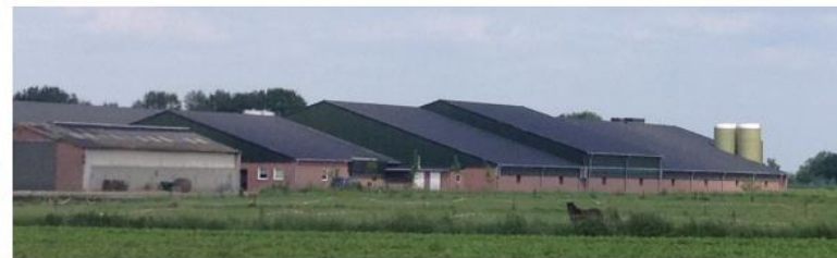
Zicht op de stallen aan de zuidzijde van het perceel, de oude stal links in het beeld wordt afgebroken.
