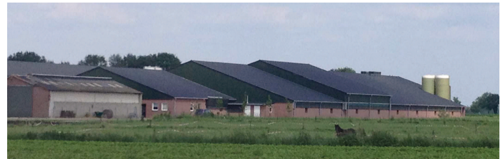
Zicht op de stallen aan de zuidzijde van het perceel, de oude stal links in het beeld wordt afgebroken.
