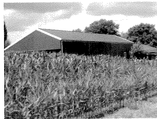
Opslag/machineberging (schuur 2b)
