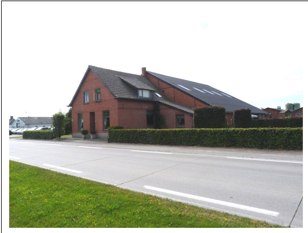
Foto 1. Te handhaven bedrijfswoning en achterhuis van Dorpsstraat 7 (deellocatie A).
