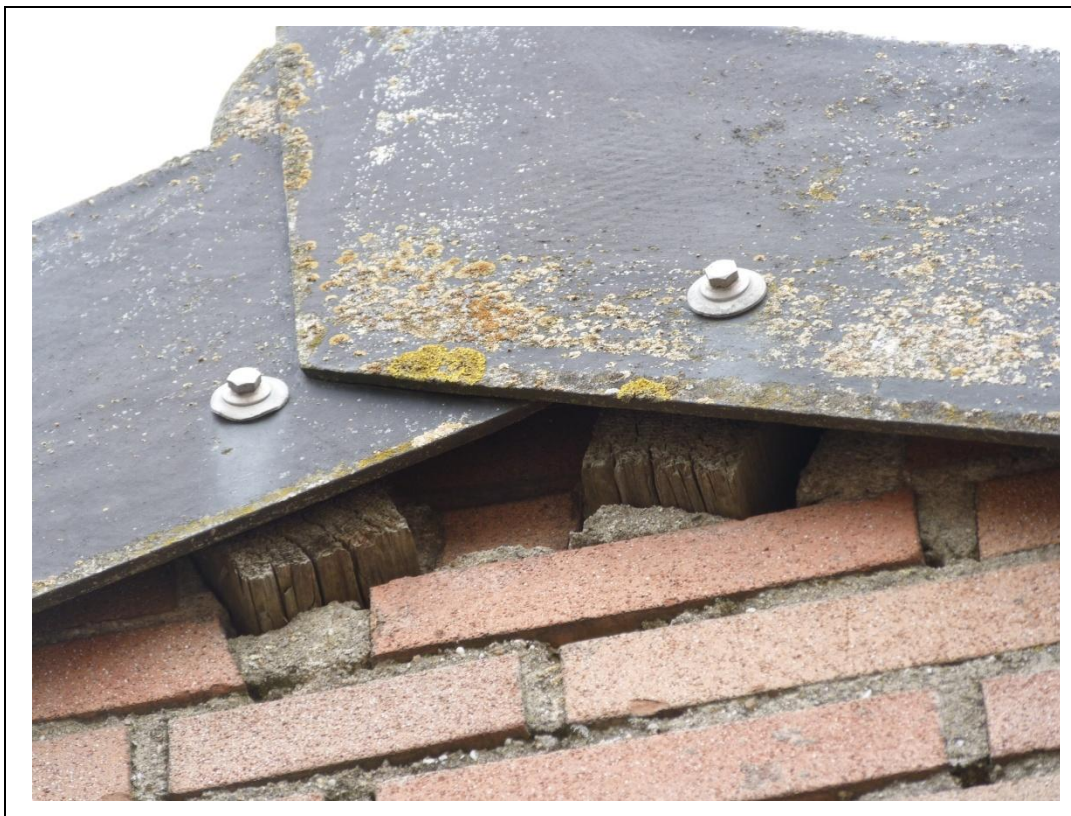
Foto 7. Eén van de geschikte openingen voor o.a. huismussen en vleermuizen.
