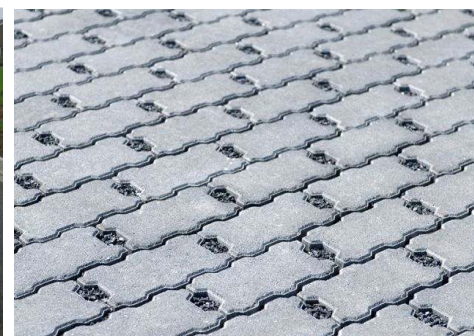
voorbeeld waterdoorlatende verharding
