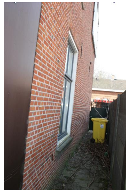
Vernieuwd venster met aan weerszijde een oorspronkelijk luikwervel.
