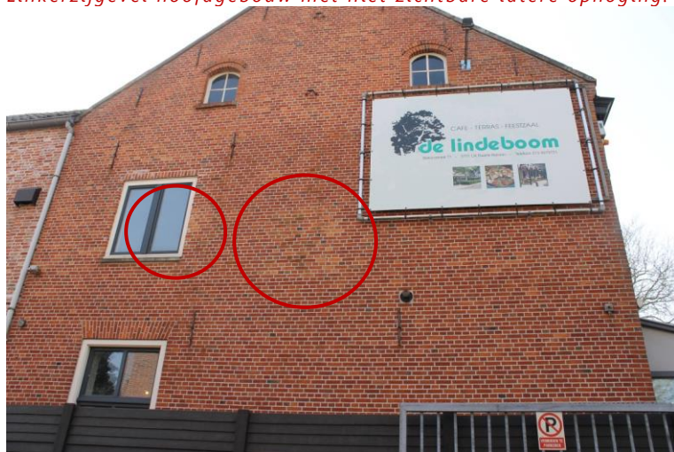
In de zijgevel is inboetwerk (cirkels) zichtbaar van de vensters in de topgevel van toenmalige eenlaagse bebouwing.
