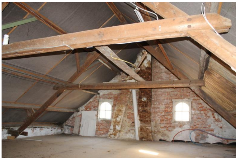
A-spanten op zolderverdieping.
