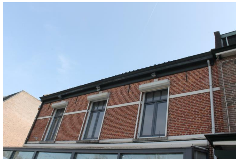
Voorgevel verdieping te dateren in derde kwart 20 ste eeuw.
