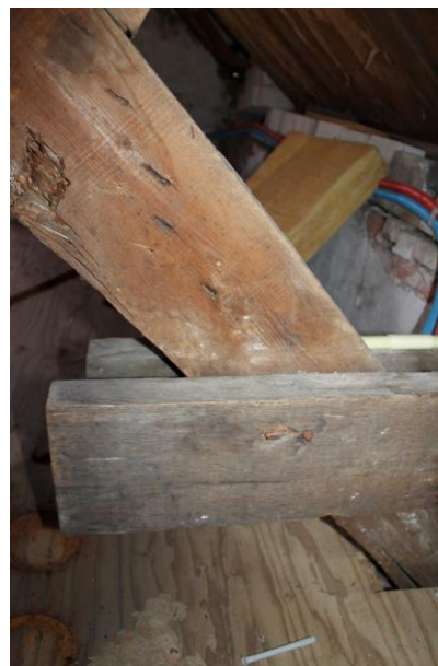
Verbinding van korbeel en blokkeel.
