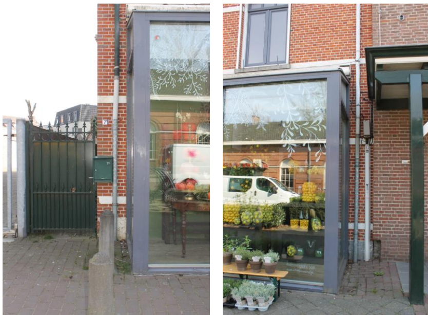
Voorgevel aan weerszijde van de latere serre met gestucte speklagen en plint.
