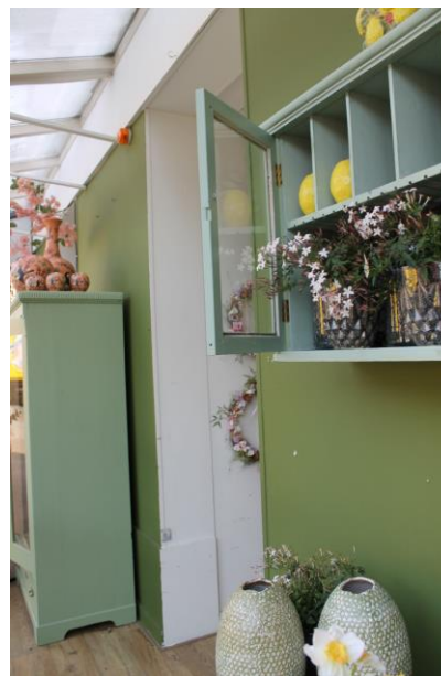
Afgetimmerde voorgevel en gevelopeningen.
