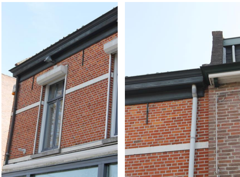
Verdieping voorgevel met gestucte speklagen en vernieuwde vensters.
