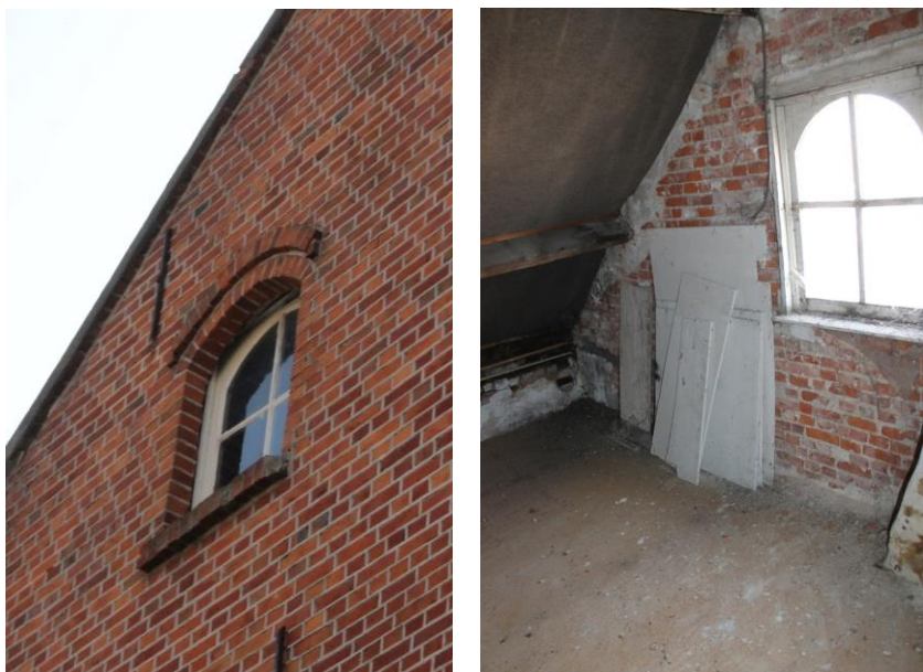
Ouder venster vermoedelijk afkomstig uit ouder topgevel en geplaatst in getoogde opening.
