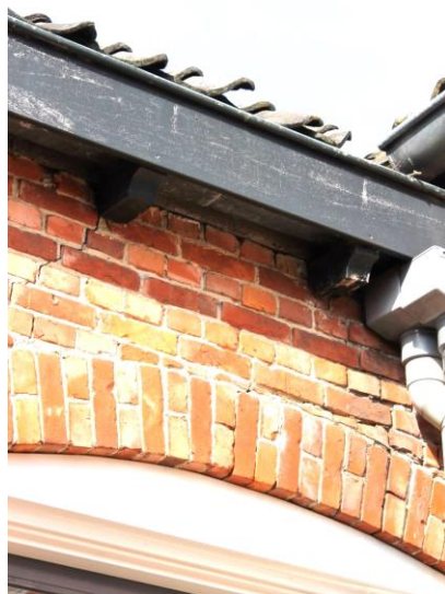
Aansluiting afgetimmerde bakgoot op klossen.
