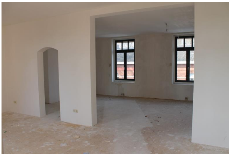
Verdieping richting voorgevel.
