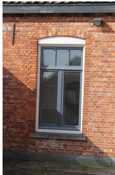
In 2010 vernieuwde vensters in achtergevel verdieping met aan weerszijde van de vensters inboetwerk.
