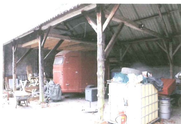
Gebintconstructie met telmerk III op de eerste balk
