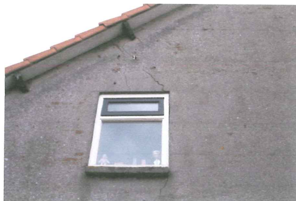
Detail met venster en dak op klossen
