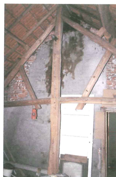
Oorspronkelijk spant
