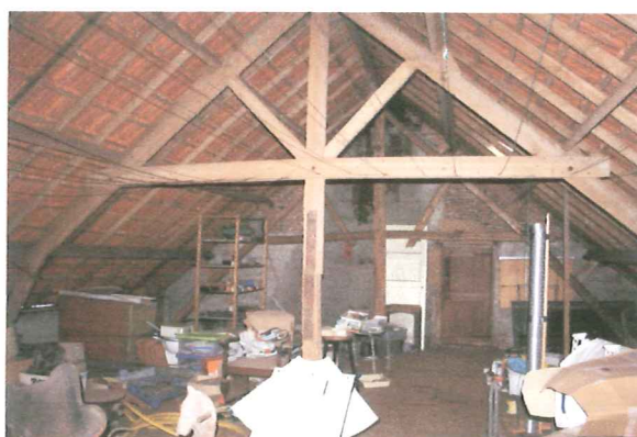
Verdieping met een nieuw en oud spant
