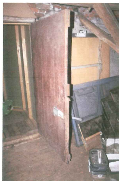
Doorgang in de brandmuur
