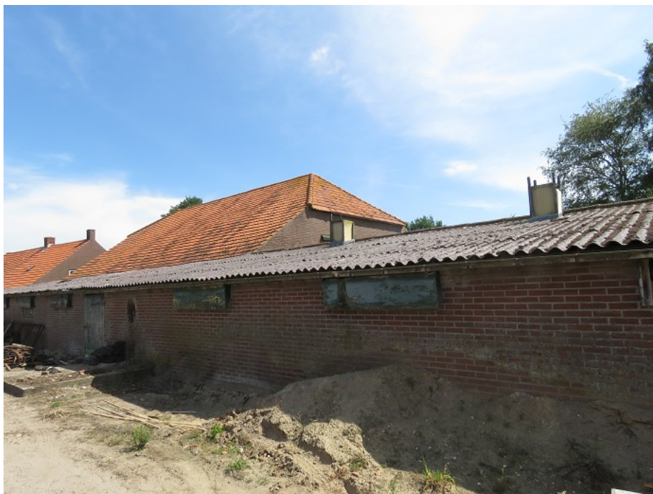
Te slopen schuur met mogelijkheden voor steenuil en kerkuil.
