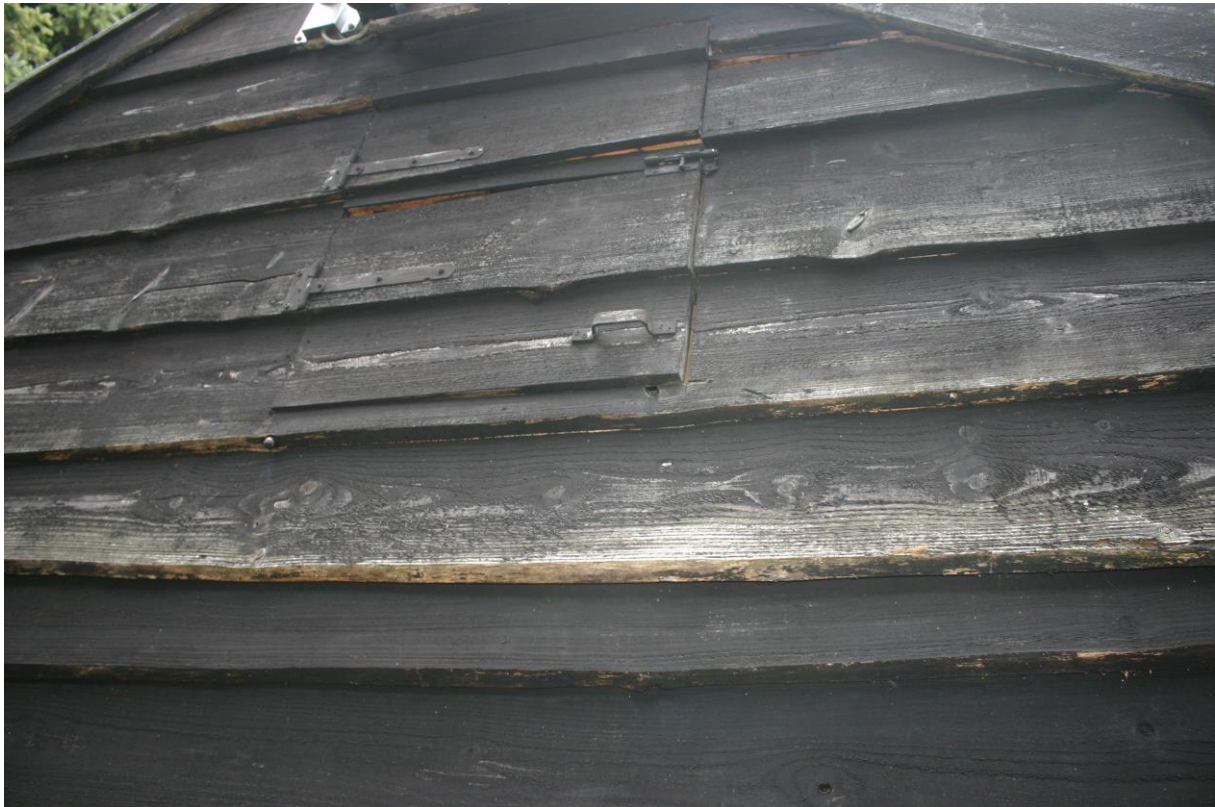
Figuur 4.2.2. De gepotdekselde wanden van het tuinhuisje bevatten vrijwel geen kieren.
