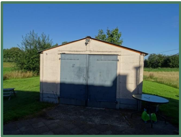
Voorzijde betonnen schuur
