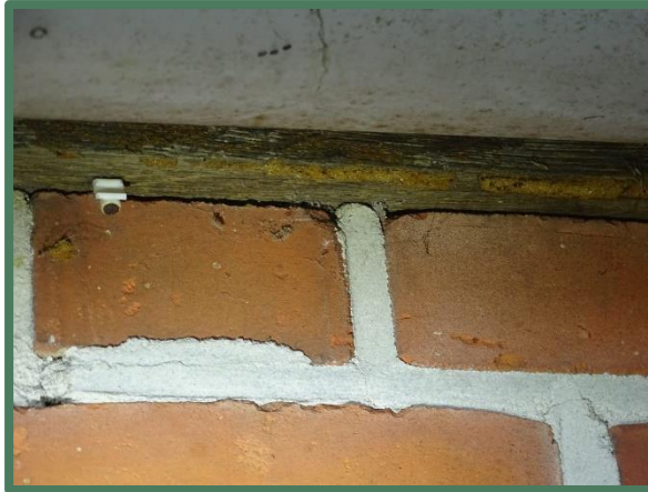
Muurplaat tussen de wand en het dak
