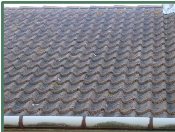
Pannendak met de eerste rij dakpannen doorstekend in de goot
