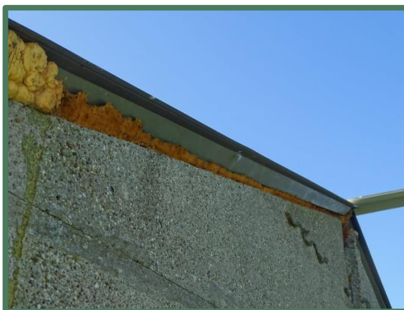
Bouwschuim tussen de wand en het golfplaten dak
