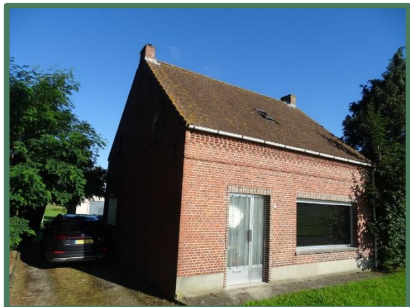
Goede staat van het dak aan de oostzijde van de woning
