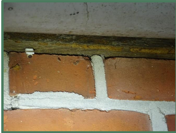
Muurplaat tussen de wand en het dak
