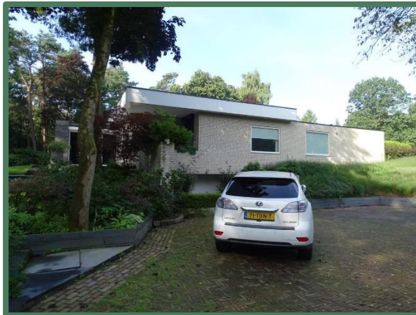
Overzicht woonhuis plangebied
